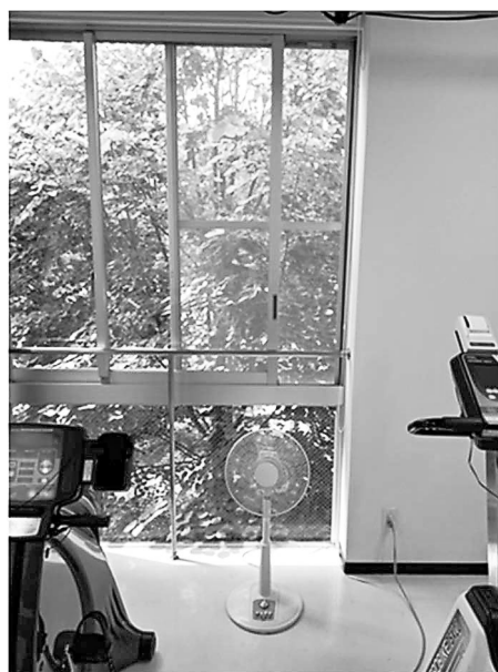
図 3. 窓開けと扇風機による換気
