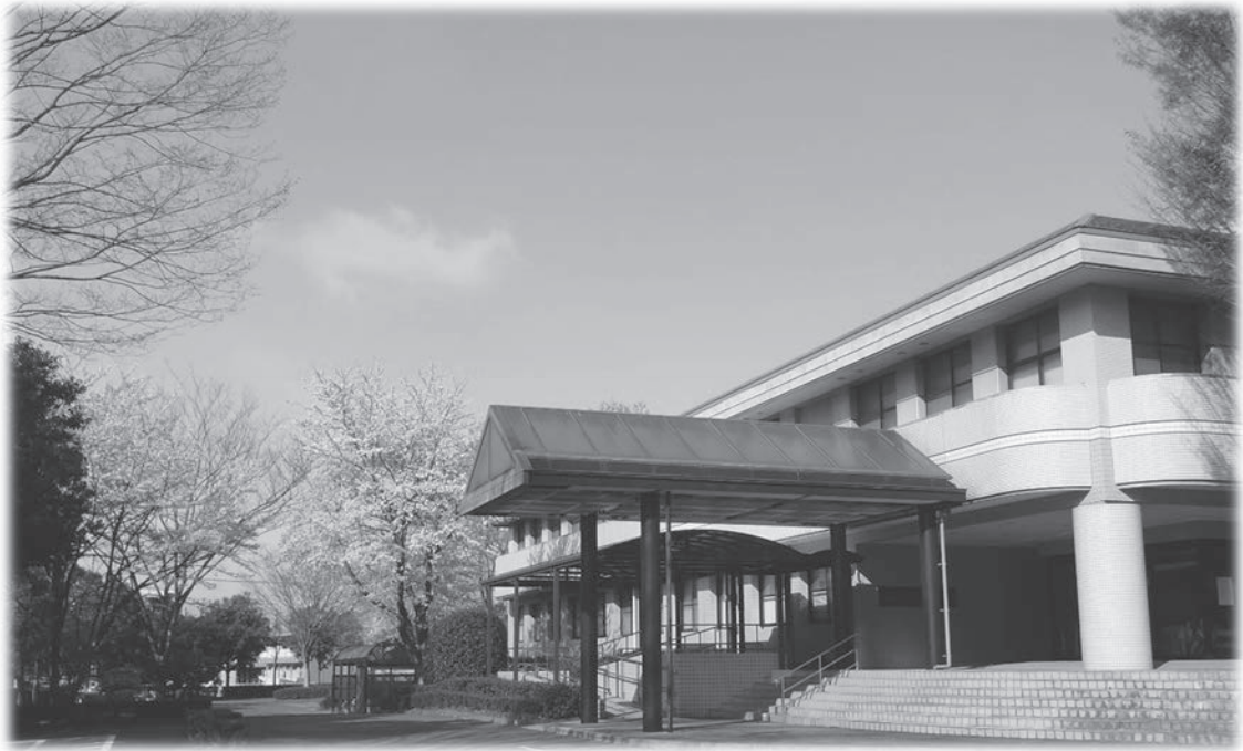
東棟エントランスを臨む
